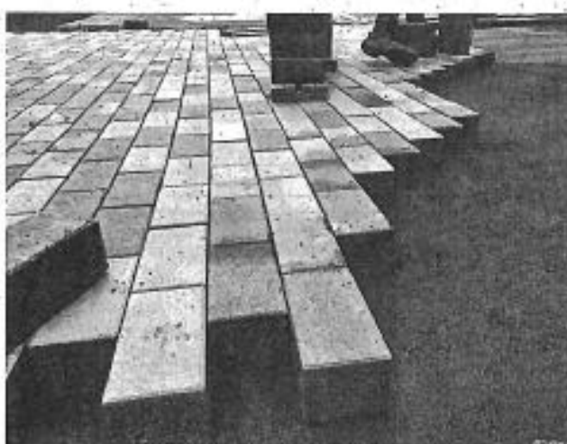
リサイクル素材を用いて製造して作成したインターロッキングブロック舗装
